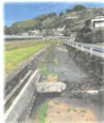
土砂・雑草の除去(伊台川)
